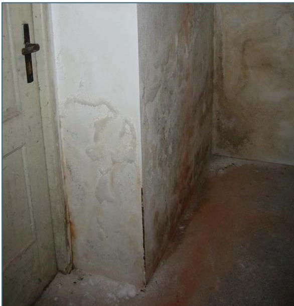
Abb. 11: Feuchteschaden im Keller mit Salzausblühungen und Schimmel durch aufsteigende und kondensierende Feuchtigkeit.
