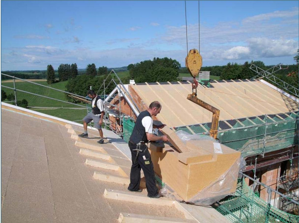
Abb. 7: Aufsparren-Dachdämmung, bei der während der Sanierung der vorhandene Dachaufbau erhalten bleibt.
