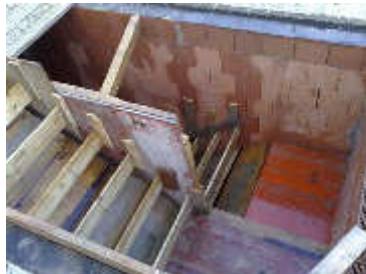
Eine fertige Treppenschalung.
