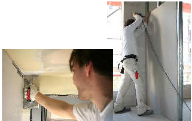
linkes Bild - Verputzen einer Innenwand. rechtes Bild - Einfügen einer Trockenbauwand
